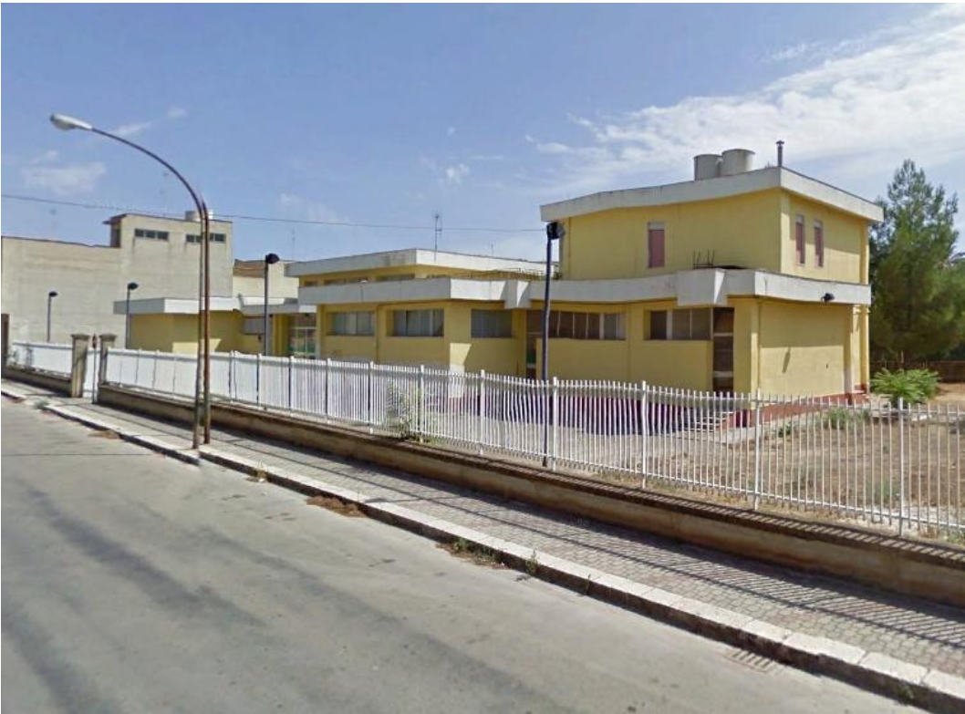
Figura 1 - Via CB 3 area C.O.C. vista laterale
