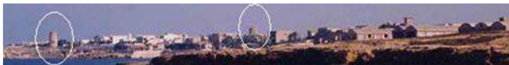
Ubicazione delle due torri (veduta da levante).
